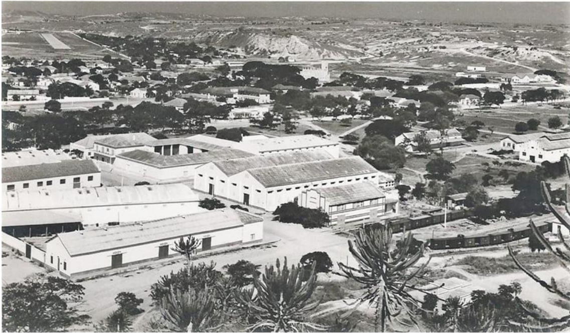
Instalações ferroviárias do C.F. Amboim. 1960
